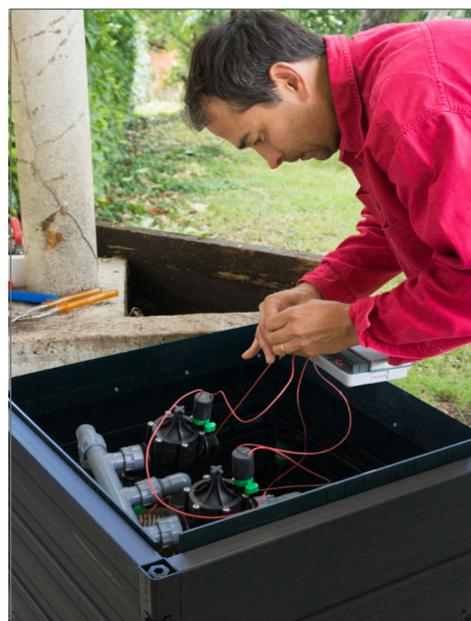
Genau hier glänzt die ROM-Box GALA durch ihre baulichen Möglichkeiten und ihre sprichwörtliche Leichtigkeit. So ist die ROM-Box GALA mit ihren Extrusionsprofilen flexibel anbohrbar, die glatten Außenwände erleichtern die Montage und Anbringung von Equipment und Einführungselementen. Die Kunststoff-Profile lassen sich mit einem Akkuschraubbohrer bearbeiten, somit kann auch an Orten ohne Stromanschluss gearbeitet werden.
